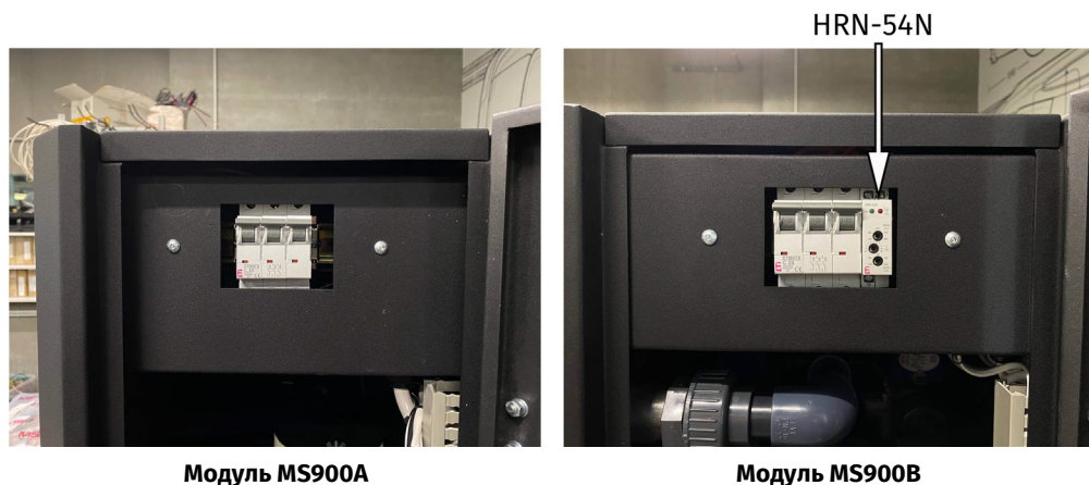
Рисунок 26. Включение автоматических выключателей
